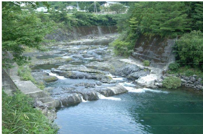
図 4-3-14 堰の本体改造によって魚介類の移動性を確保した事例 四万十川水系北川川
