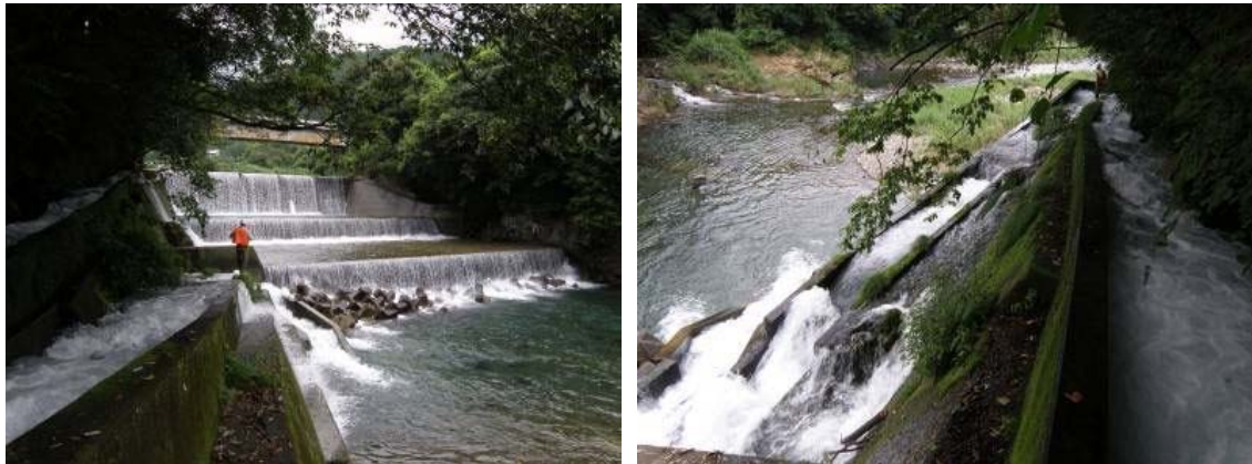
砂防堰堤 No.2 魚道が設置されているものの、白泡・乱流の発生により遡上困難
