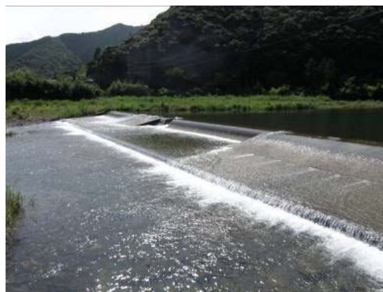
伊才野頭首工 魚道が設置されておらず、遡上障害となっている
