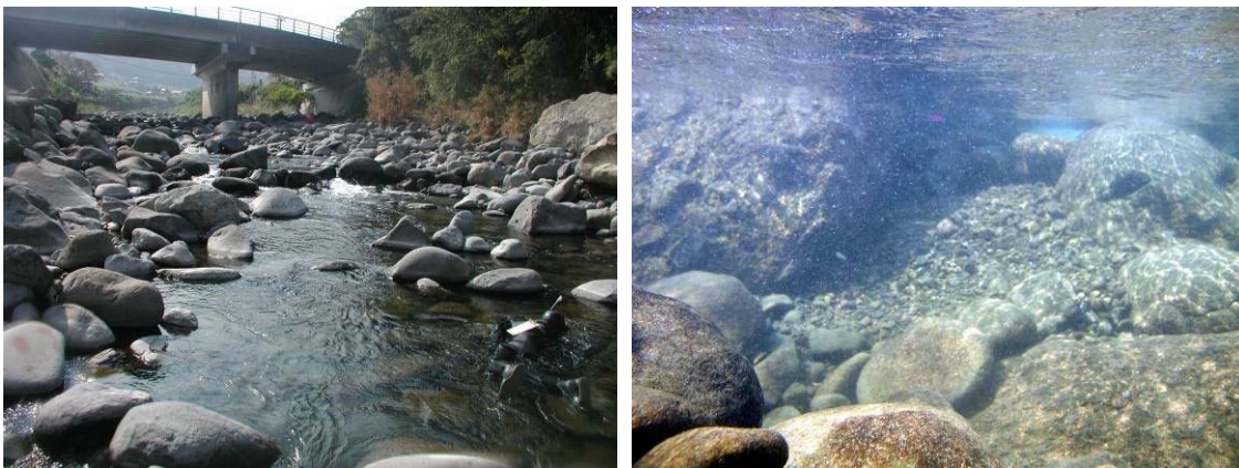
福岡県岩岳川に設置された分散型落差工（左）とその水中の状況（右） ステップ・プールが明瞭で小砂利がよく補足されている
