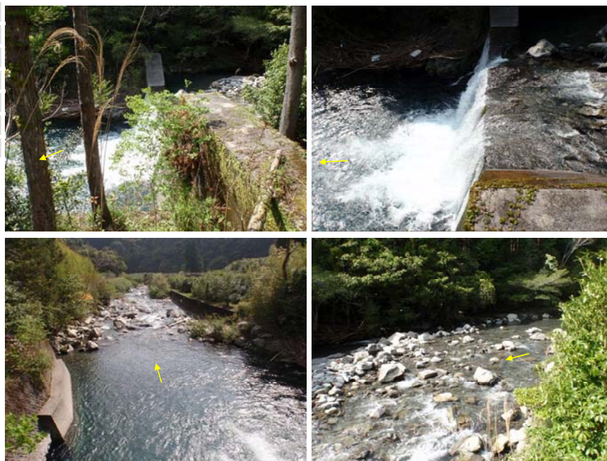
図 3-7-2 (3) 現地踏査により確認した横断構造物
