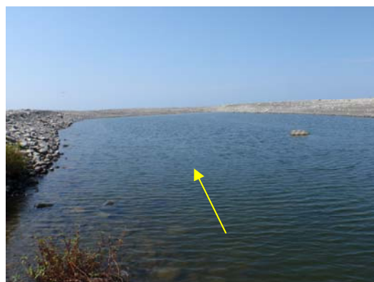
西の川河口の閉塞状況（2010年9月）
