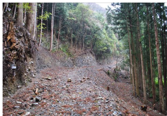
新しい作業道。作業道の開設にあたっては、路面の排水に十分に配慮し、路面や路肩等の侵食を未然に防ぐことが重要となる。
