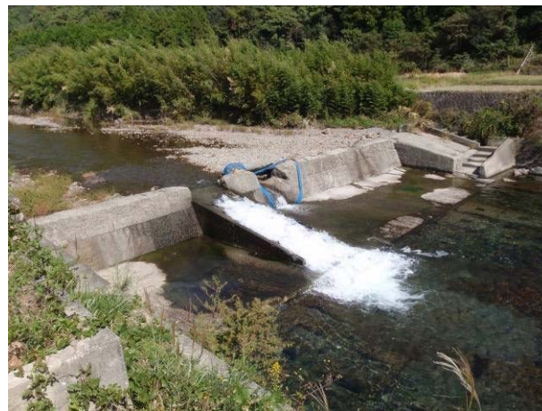
寺田頭首工 (2009 年 10 月 23 日)
