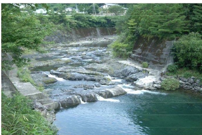
図 4-3-10 堰の本体改造によって魚介類の移動性を確保した事例 四万十川水系北川川
