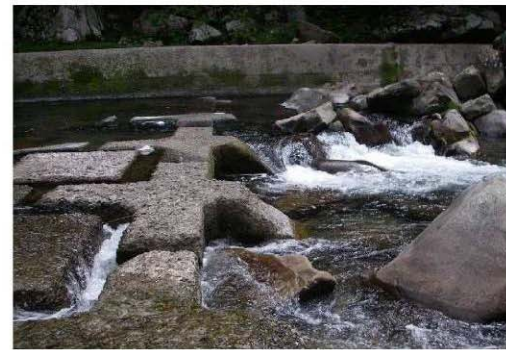
③左岸側の十字ブロック下流端の状況
