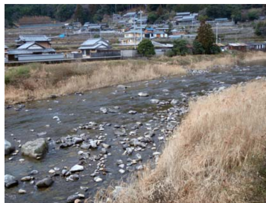
安田川下流域の状況（東島頭首工上流付近）
