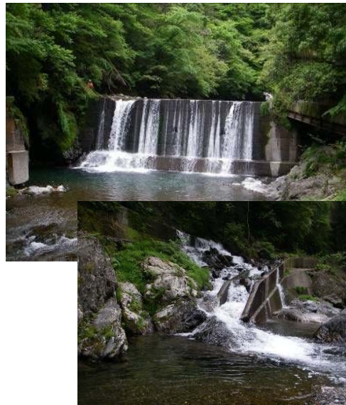
大平ダムと設置された魚道
