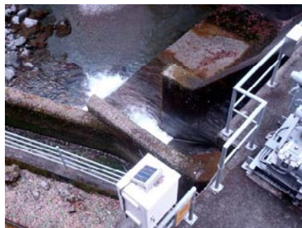
図 3-7-2 (4) 現地踏査により確認した横断構造物
