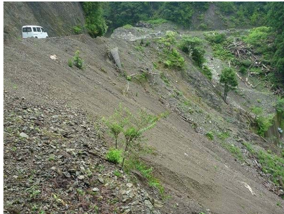
林道が発端になったと考えられる崩壊の事例。車が停車している山側には高い切土がある。谷側の土砂は絶えず移動しており、土砂の発生源であるとともに、植生の回復も難しい。
