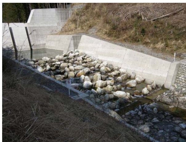
砂防堰堤に設置された階段式全断面魚道 仁淀川水系成川
