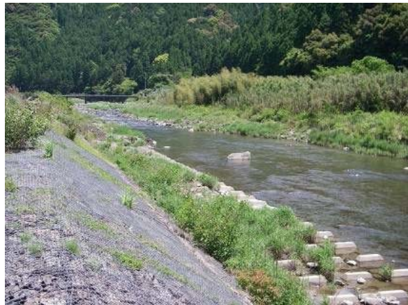
河床低下が確認された直線河道
