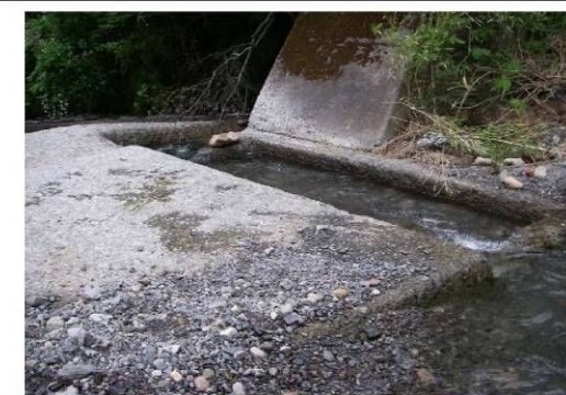
②魚道Aの上流端の状況
