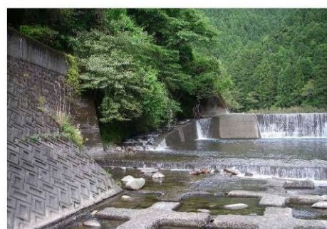
③魚道Aの下流側の状況
