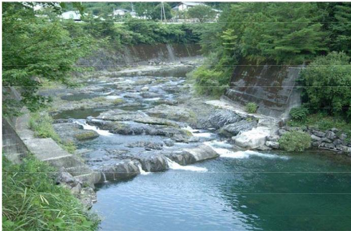
図 4-3-10 堰の本体改造によって魚介類の移動性を確保した事例
