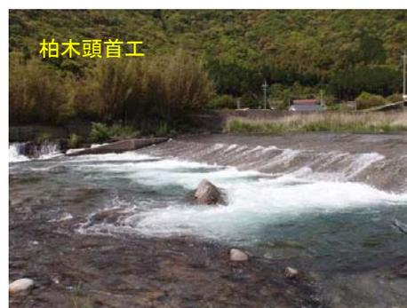
以上のように、羽根川下流域に設置されている頭首工は、遡上が困難な状態ではないものの、円滑に遡上できる状態にはない。特に、牛ヶ島頭首工の右岸側魚道と柏木頭首工の同じく右岸側魚道は改良すべき課題が残されている。
