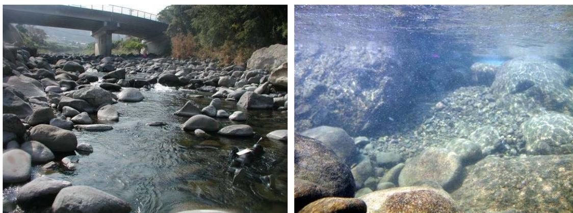
福岡県岩岳川に設置された分散型落差工（左）とその水中の状況（右）
