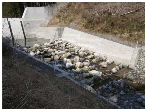
砂防堰堤に設置された階段式全断面魚道
