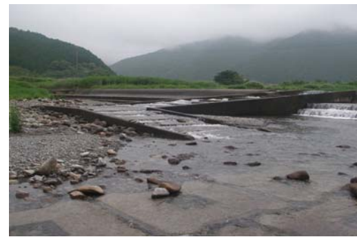
⑤中央部魚道の状況
