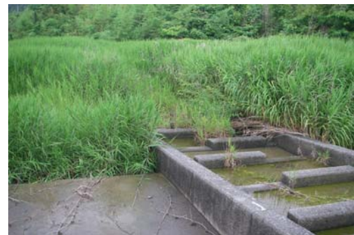
⑥右岸側魚道の状況
