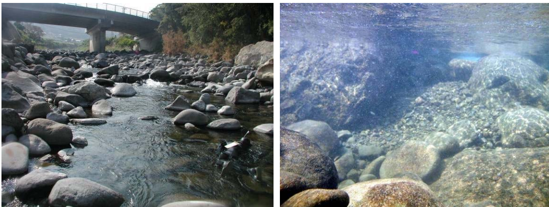
福岡県岩岳川に設置された分散型落差工（左）とその水中の状況（右） ステップ・プールが明瞭で小砂利がよく補足されている
