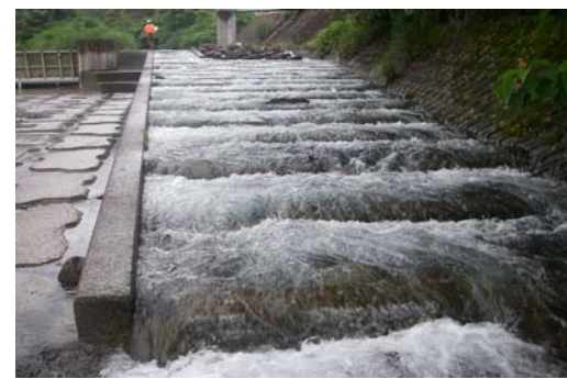
④左岸側魚道の状況
