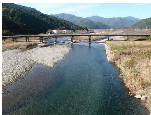
河口周辺（野根大橋上流）
