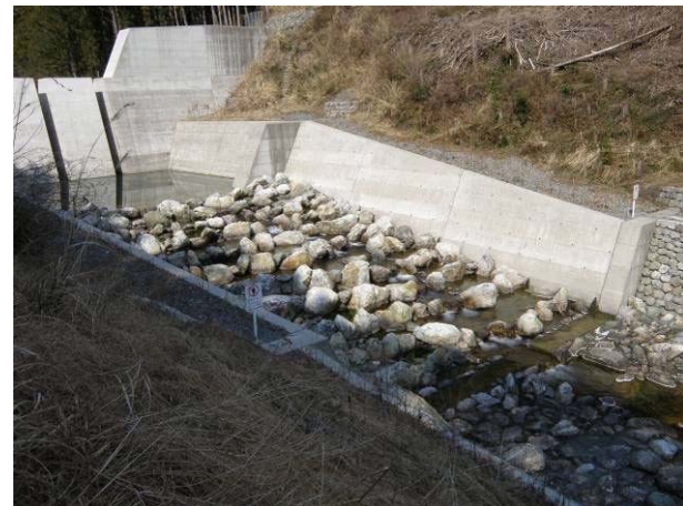
砂防堰堤に設置された階段式全断面魚道 仁淀川水系成川
