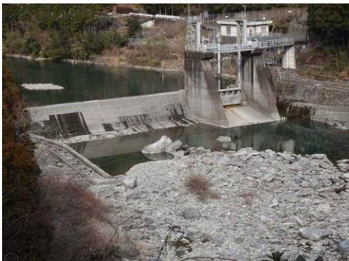
取水堰堤（土居川発電所へ）
