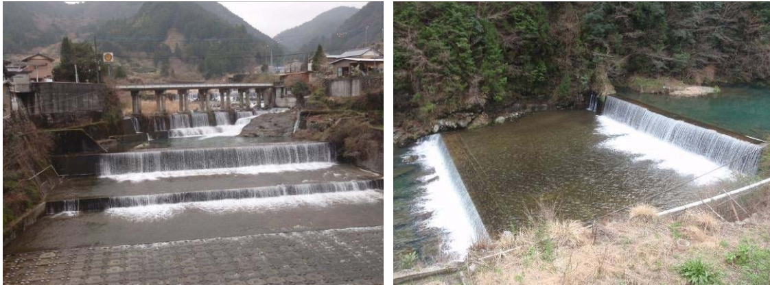
長者川の砂防堰堤（左；河口から 73.3km、右；河口から 73.8km）
