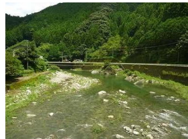
上八川川の河畔林のない区間 （広瀬地区）
