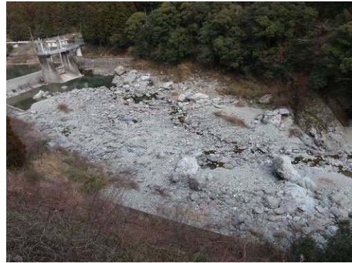
堰下流減水区の状況
