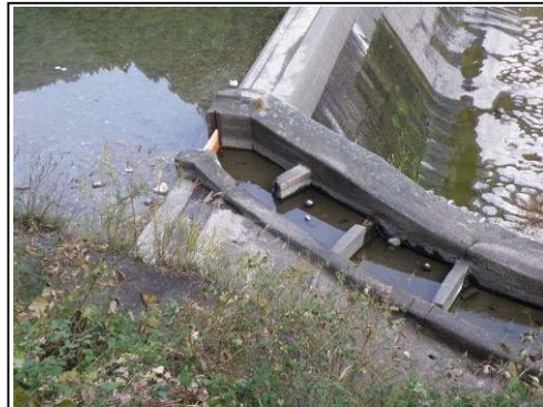
改善対策 ■魚道への流量調整（通水） なお、当魚道から常時下流へ放流することにより、環境維持流量の一部も確保できよう。
