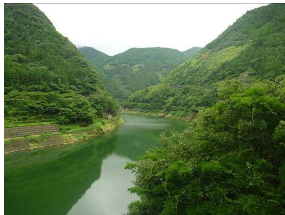
仁淀川の県内上流域は、本川、支川ともに急傾斜地が多い。(大渡ダム湖畔)
