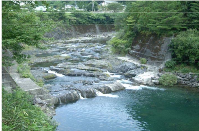
図 4-3-9 堰の本体改造によって魚介類の移動性を確保した事例 四万十川水系北川川
