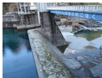
上八川川分水第4発電所堰堤 下流への放流は確認できない
