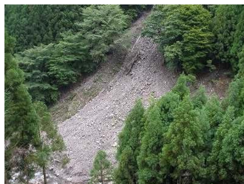
河岸の崩壊箇所（土居地区）
