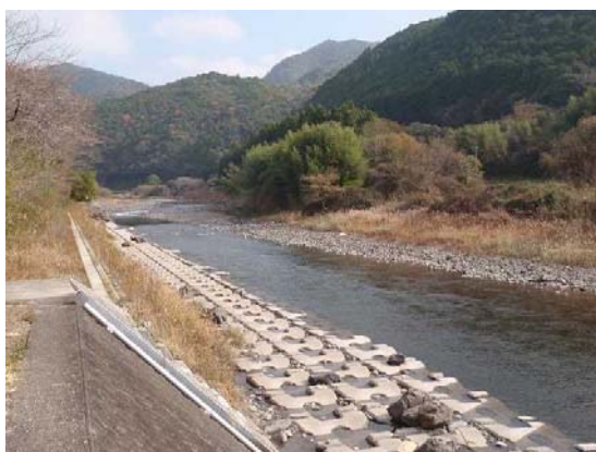
正常流量区 (放水口下流宮田岡付近)
