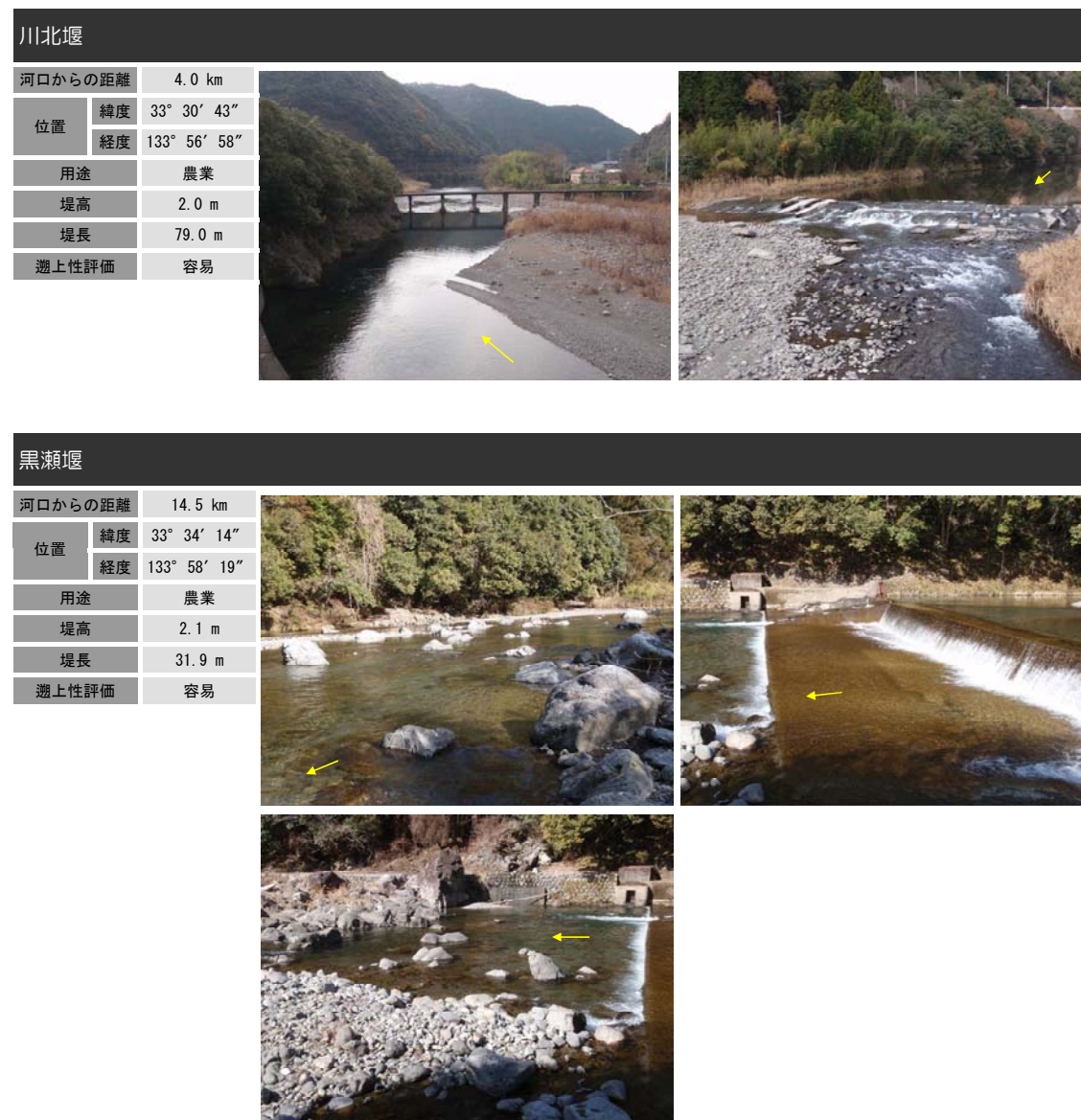
図 3-7-2 (1) 現地踏査により確認した横断構造物
