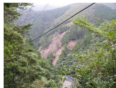
上流部の崩壊箇所
