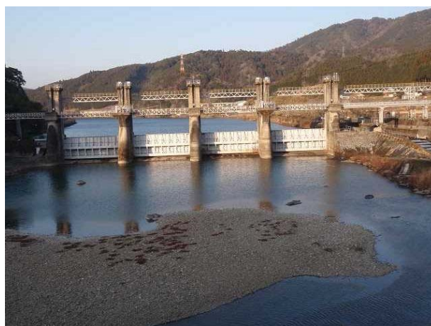
家地川堰堤（佐賀発電所へ）
