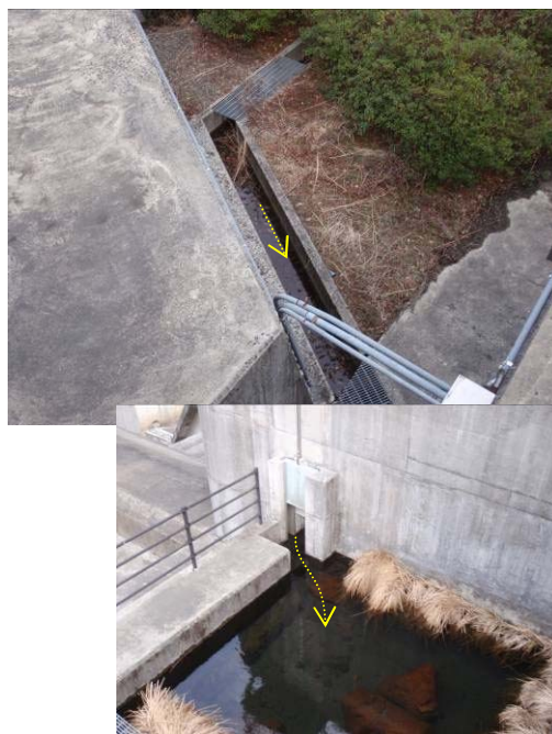
坂本ダムに設置されたエビ・カニ類用の魚道
