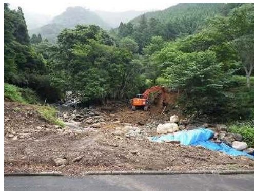
黒尊川上流支川の工事箇所
