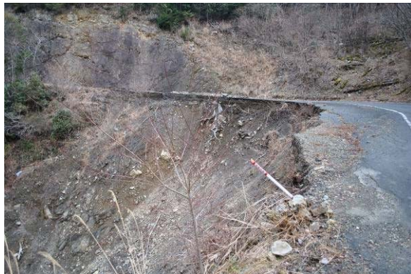
林道の谷部における崩壊。舗装の有無に関係なく、水が集まる場所は崩壊の危険性が非常に高い。崩壊部の土砂が安定するまでは、土砂の発生源になるとともに、植生の回復も難しい。（四万十川中流域旧十和村）
