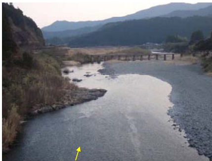
図 3-6-2 (2) 現地踏査により確認した横断構造物
