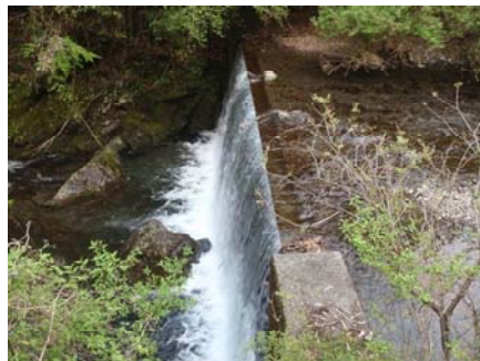
図 3-6-2 (10) 現地踏査により確認した横断構造物
