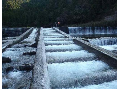
安田川に新設されたハーフコーン型魚道
