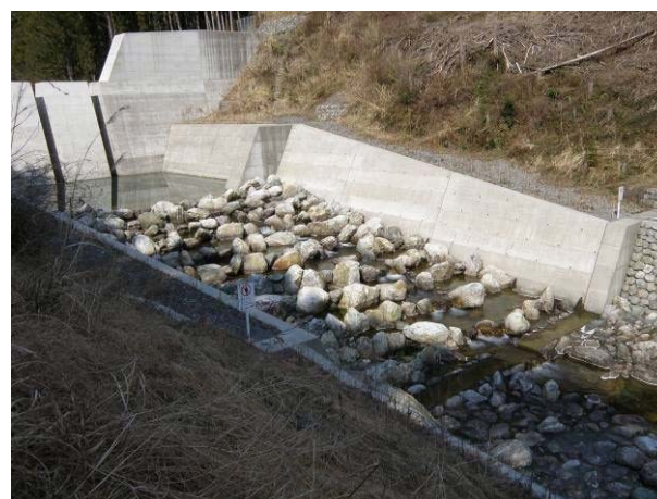
砂防堰堤に設置された階段式全断面魚道 仁淀川水系成川
