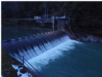
図 3-6-2 (6) 現地踏査により確認した横断構造物
