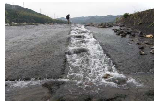
②左岸側魚道の状況
