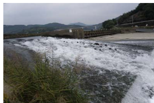
⑤右岸側魚道の流況
