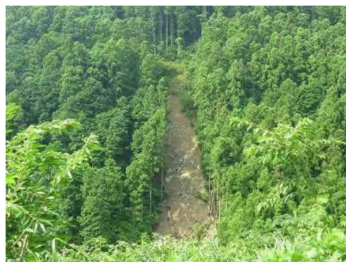
吉原川の河岸の崩壊箇所（谷口地区）
