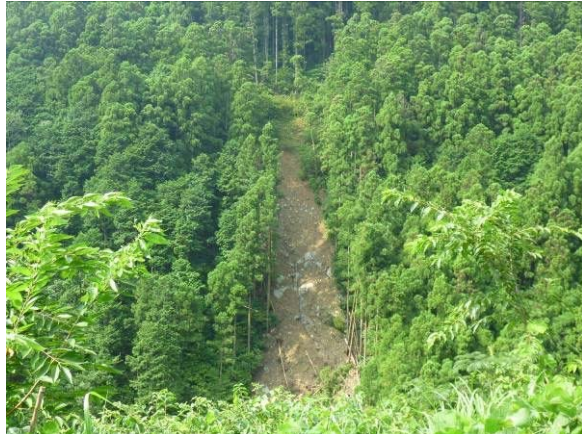
支川吉原川で確認された林道が発端と考えられる崩壊。崩壊は河川まで到達していた。
