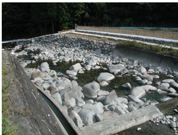
溪床復元型全断面魚道 福岡県岩岳川に設置された
