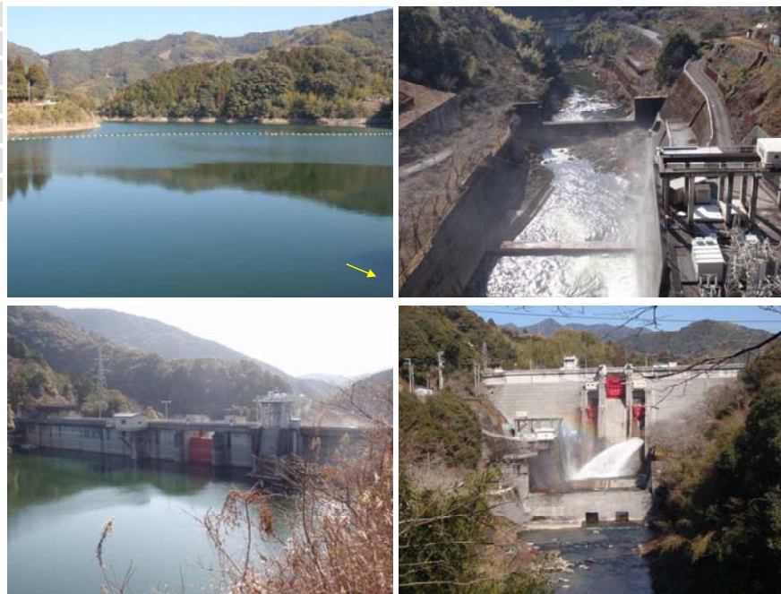
図 3-7-2 (2) 現地踏査により確認した横断構造物
