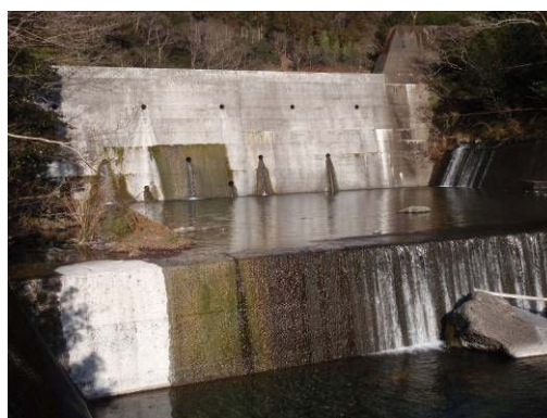
高川川の最下流に位置する砂防堰堤
