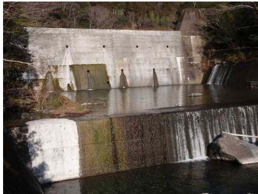
高川川の最下流に設置された砂防堰堤
