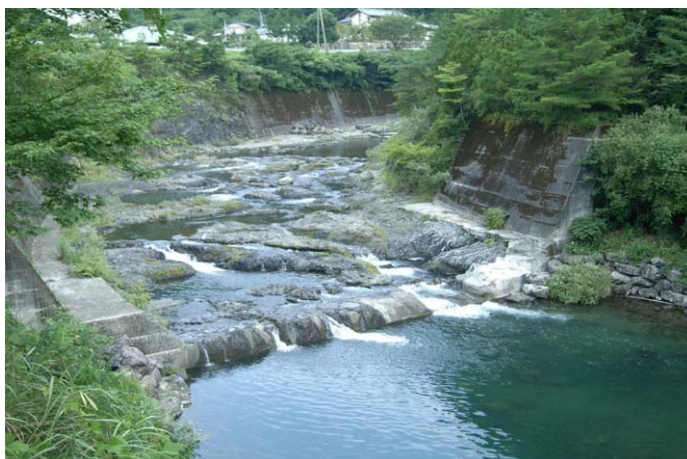
図 4-3-10 堰の本体改造によって魚介類の移動性を確保した事例 四万十川水系北川川
