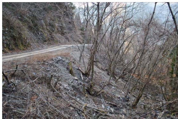
林道沿いにみられる土砂の崩落。絶えず土砂が移動すると、植生の発達は期待できない。
