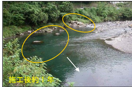
事例：安田川（馬路地区）に水制工による再生された淵 石材を使用した水制を水衝部に設置し、その下流側に淵を創出。
