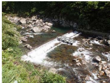
安田川（東瀬切頭首工）
