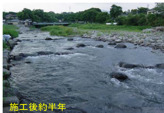
事例：熊本県菊池川水系迫間川に設置された分散型落差工 河岸の浸食防止と瀬の環境改善を目的に施工された
