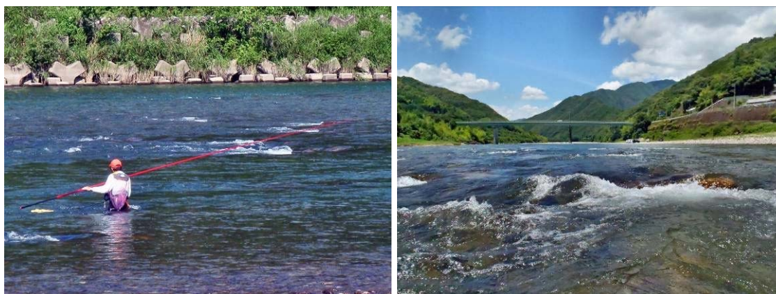
事例：近自然工法により再生された仁淀川中流域柳ノ瀬の漁場 施工前は小石底の平坦な平瀬であった
