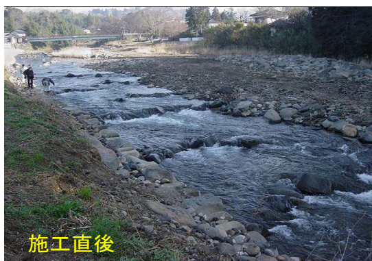
事例：熊本県菊池川水系迫間川に設置された分散型落差工 河岸の浸食防止と瀬の環境改善を目的に施工された
