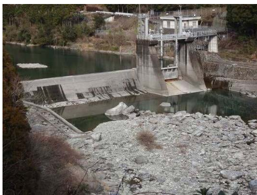
取水堰堤（土居川発電所へ）
