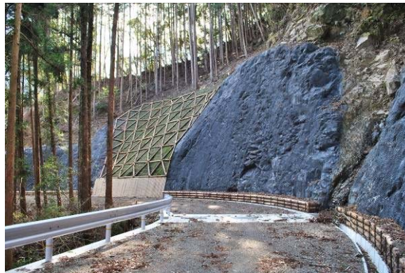
赤野川上流域で改修が進められている林道。急傾斜地で道路の幅員を確保するため、斜面が大きく切り取られている。林道開設は、場合によっては山腹崩壊の原因になる恐れがある。
