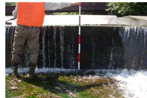
⑧堰堤の落差状況
