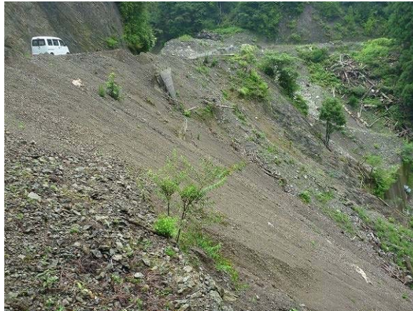
林道が発端になったと考えられる崩壊。車が停車している山側には高い切土がある。谷側の土砂は絶えず移動しており、土砂の発生源であるとともに、植生の回復も難しい。
