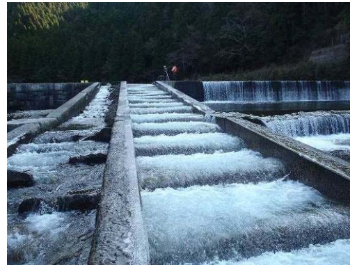
安田川に新設されたハーフコーン型魚道
