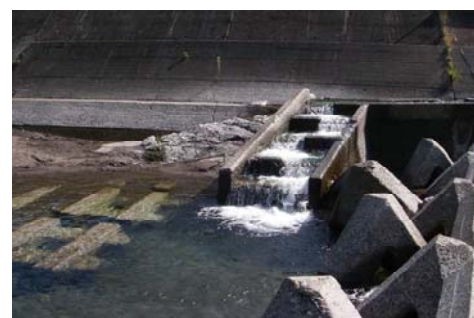
⑥右岸側魚道の下流端の状況
