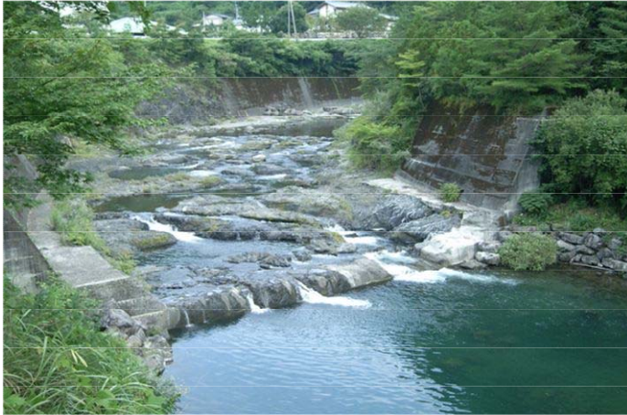
図 4-3-8 堰の本体改造によって魚介類の移動性を確保した事例 四万十川水系北川川
