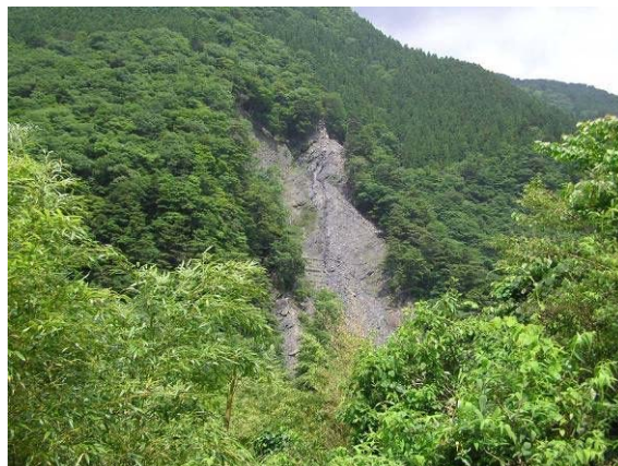
物部川上流域は、大小かかわらずしばしば崩壊が発生し、濁水の要因となっている。 （上斐生川上流）
