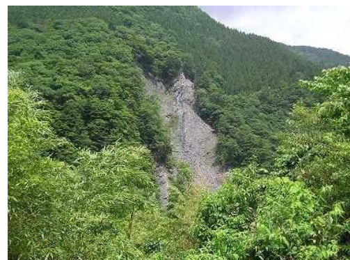
上韮生川上流部の河岸の崩壊箇所
