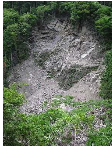
河岸の崩壊箇所（市宇地区）
