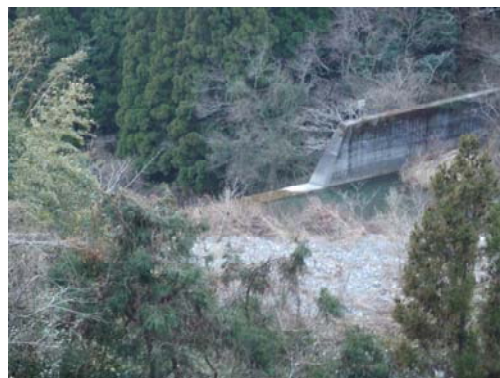
川ノ内川に設置された横断構造物
