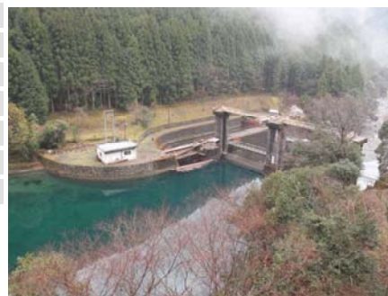
図 3-6-2 (3) 現地踏査により確認した横断構造物
