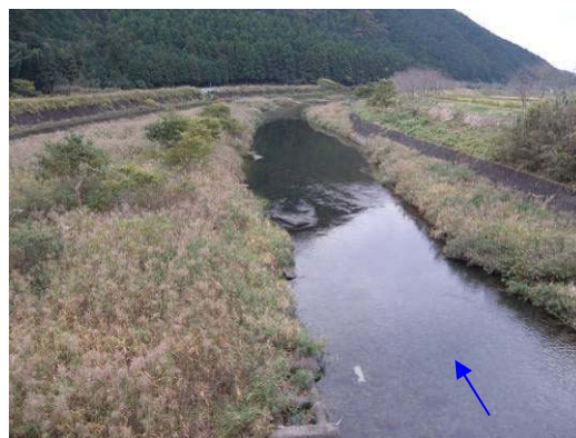
樋の口橋下流の瀬(トロ)の状況
