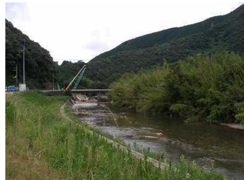
支川篠川の河畔林のない区間 (二ノ宮地区)
