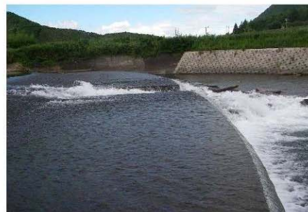
④魚道の上流端の状況
