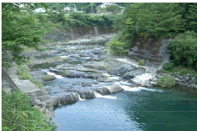
図 4-3-11 堰の本体改造によって魚介類の移動性を確保した事例 四万十川水系北川川
