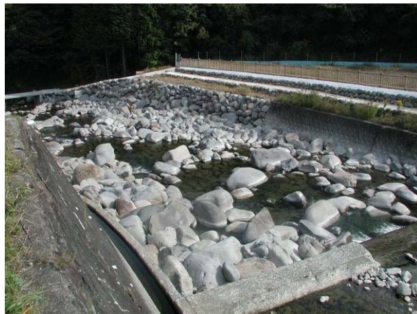
溪床復元型全断面魚道 福岡県岩岳川に設置された
