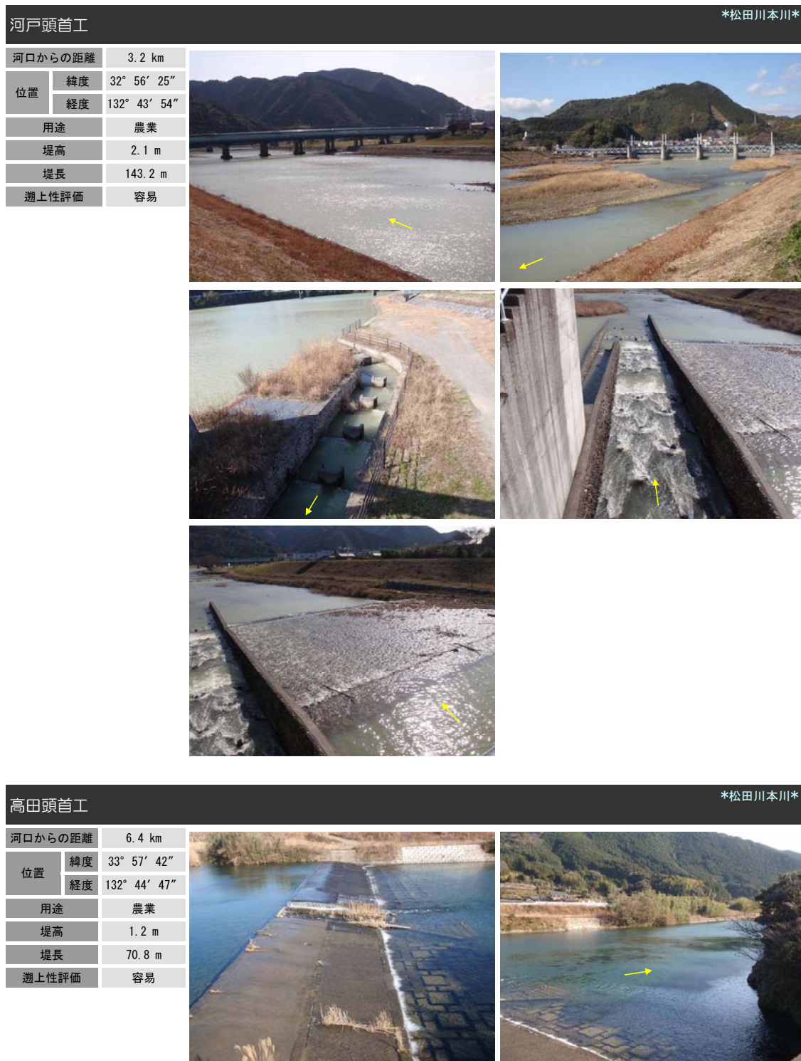
図 3-7-2 (1) 現地踏査により確認した横断構造物
