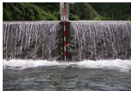
⑥本堤の落差状況
