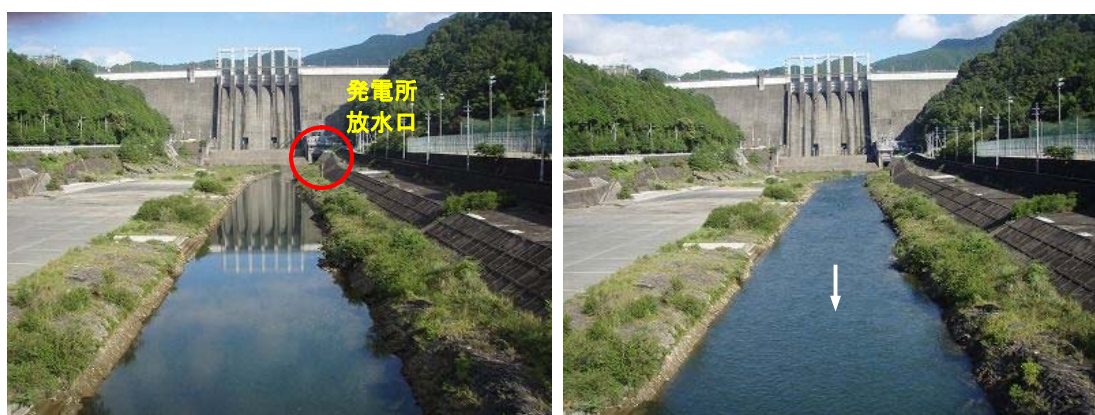
早明浦発電所からの放流が停止中（左）と放流中（右）の状態
