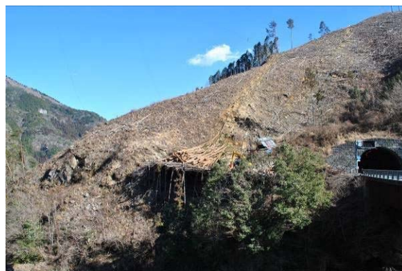
河川に面した斜面の皆伐地。河畔は広葉樹で早急に緑化することが望ましい。
