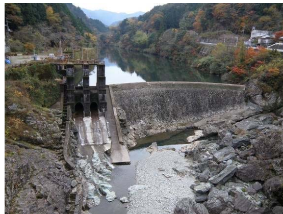
高敷取水堰堤
