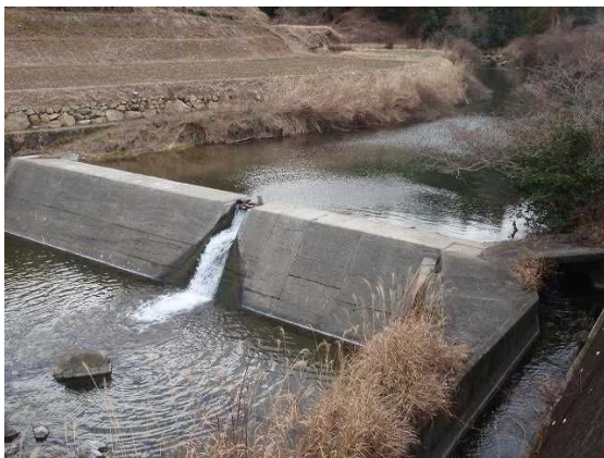
下井堰（左）と上井堰（右） 構造はほぼ同じで、魚道は設置されていない
