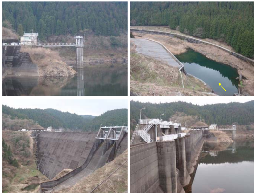
図 3-6-2 (4) 現地踏査により確認した横断構造物
