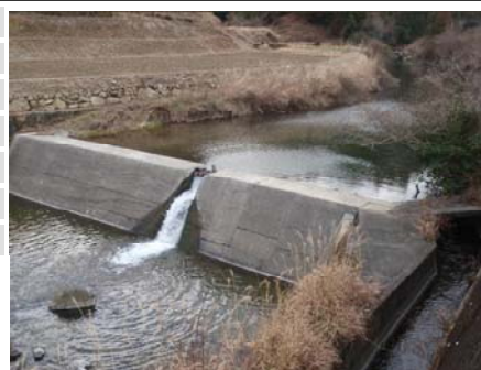
図 3-6-2 (6) 現地踏査により確認した横断構造物
