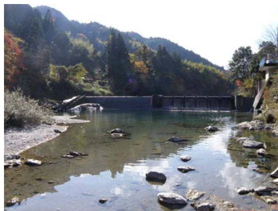
地蔵寺川最下流に設置された新井堰
