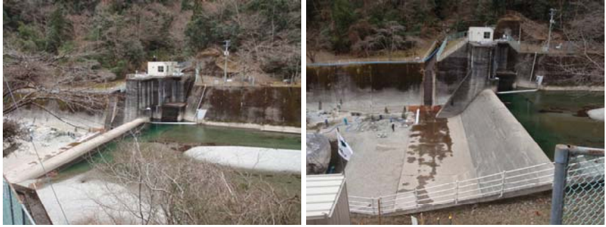
図 3-6-2 (7) 現地踏査により確認した横断構造物
