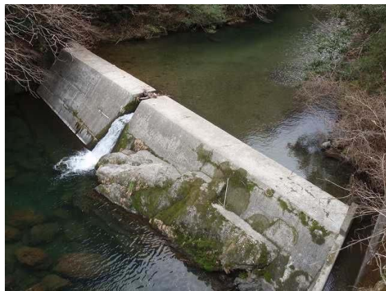
下井堰（左）と上井堰（右） 構造はほぼ同じで、魚道は設置されていない
