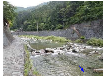
河岸が道路擁壁の区間 （葛原川桑瀬地区）
