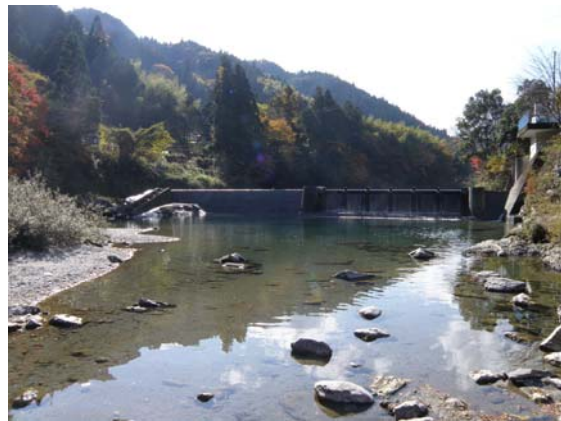
地藏寺川最下流に設置された新井堰
