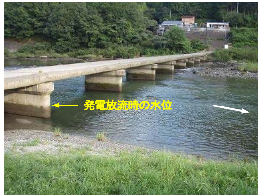
下津野沈下橋（本山橋～山崎調整池の間）の水位変動（2011年8月）
