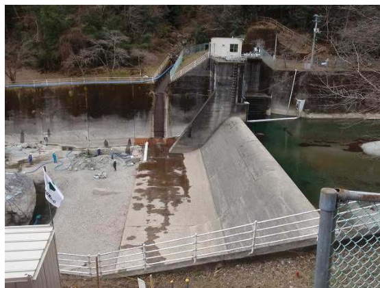
瀬戸川取水堰
