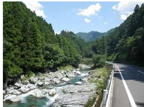
河川林のない区間（立川川一ノ瀬地区） 河岸が道路擁壁となっている区間。
