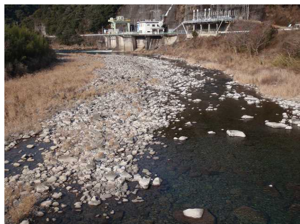
長山発電所上流の状況
