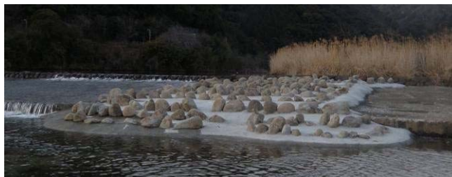
田野堰に新設された粗石付き斜路魚道
