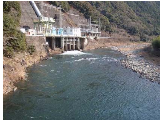
長山発電所・放水口
