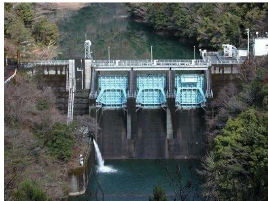
久木ダムからの維持流量の放流
