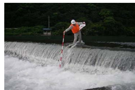
⑥ 中央部本堤の落差状況
