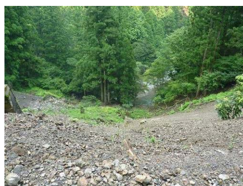
河岸の崩壊箇所(支川東川)
