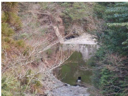
東川下流に設置されている砂防堰堤
