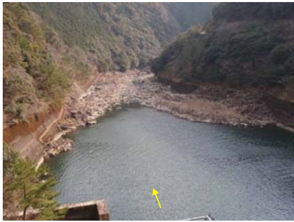
図 3-7-2 (2) 現地踏査により確認した横断構造物
