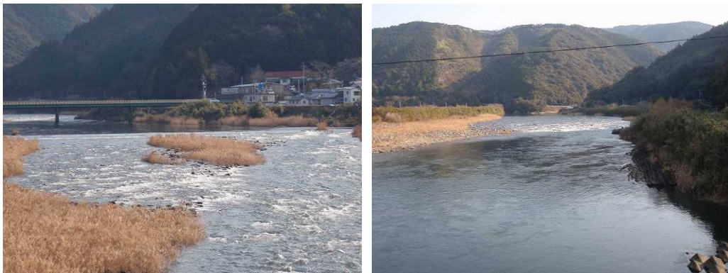
長山発電所より下流の状況
