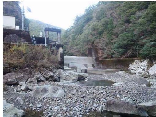
小川川に設置された発電用取水堰
