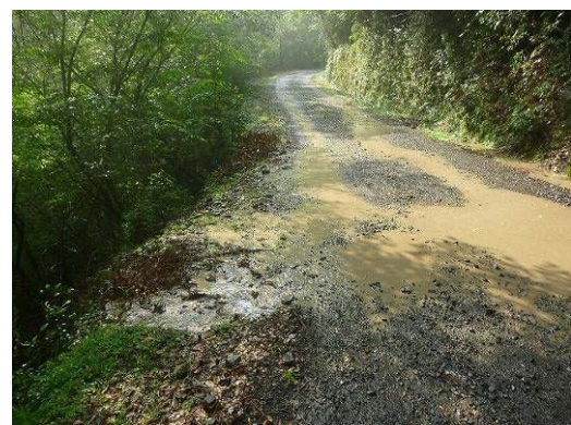
林道を流下し谷川へ流れ落ちる濁水 (魚梁瀬ダム上流支川中川)
